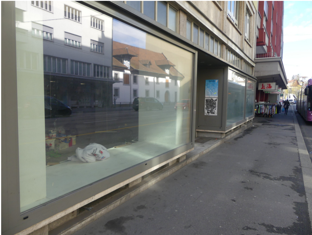
Noch befindet sich das Lokal am Hirschengraben 41 im Umbau.
